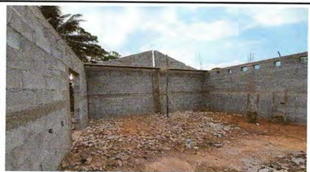
Foto 4: Nivelación de la tierra para luego la fundición de piso.
