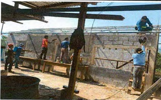
Foto 5: Colocación de costaneras.
