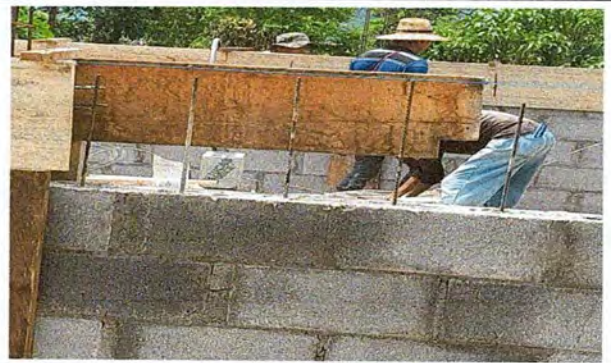
Foto 2: Fundición de soleras.
