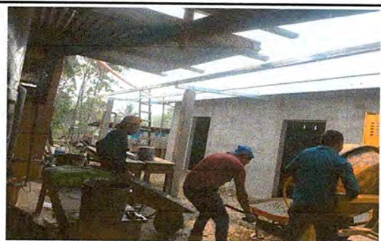
Foto 6: Colocación de lámina.
